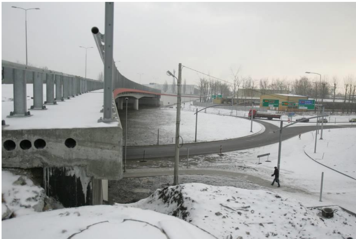
Budowa DTŚ, okolice węzła ul. de Gaulle'a
