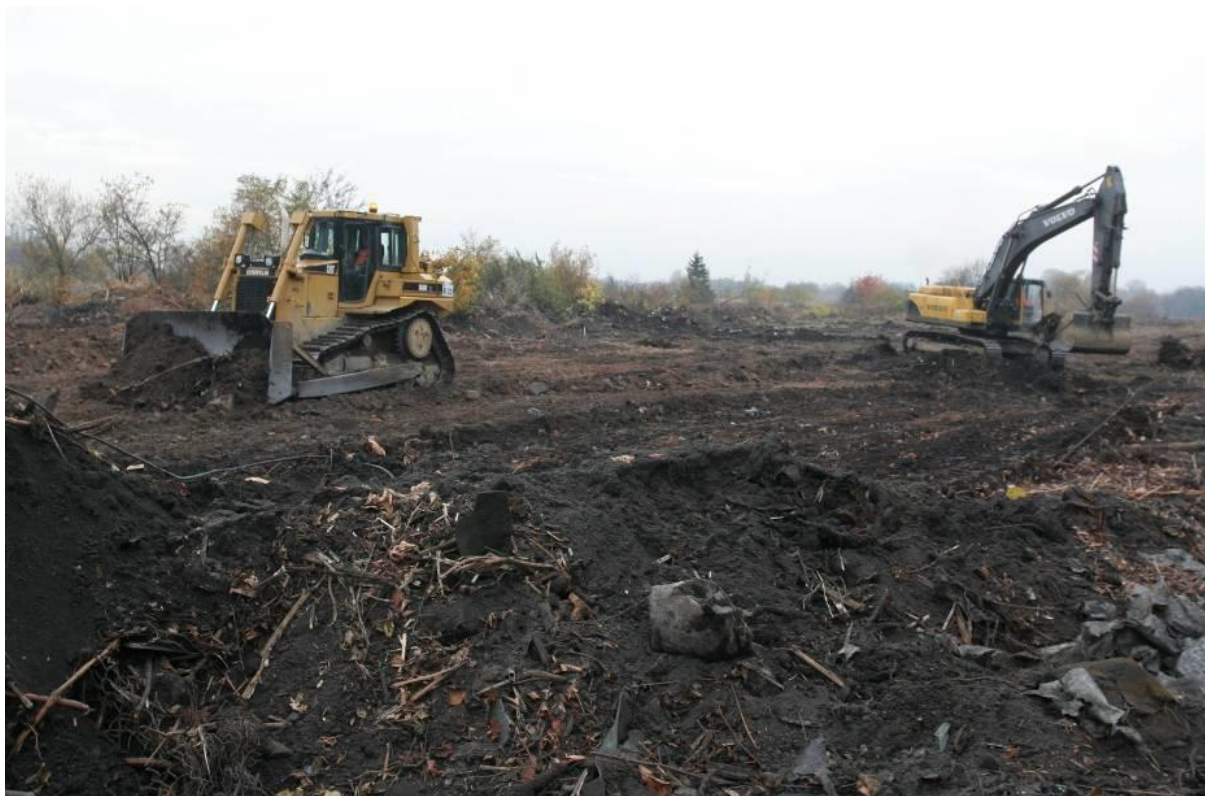
Wyrównywanie (niwelacja) terenu pod budowę DTŚ, okolice pętli tramwajowej na Zaborzu
